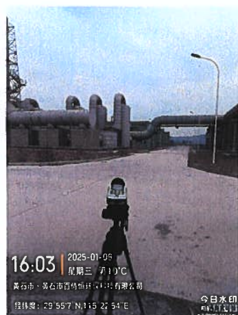
预处理工程厂界西侧1米处
