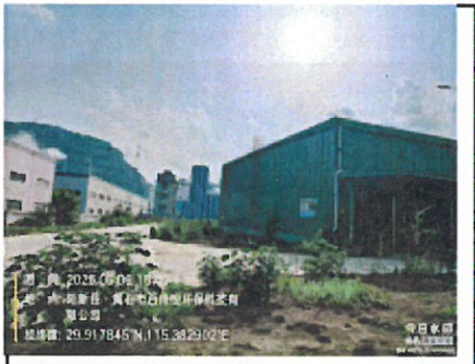
2井丙类库外s1土壤采样点西方情形
