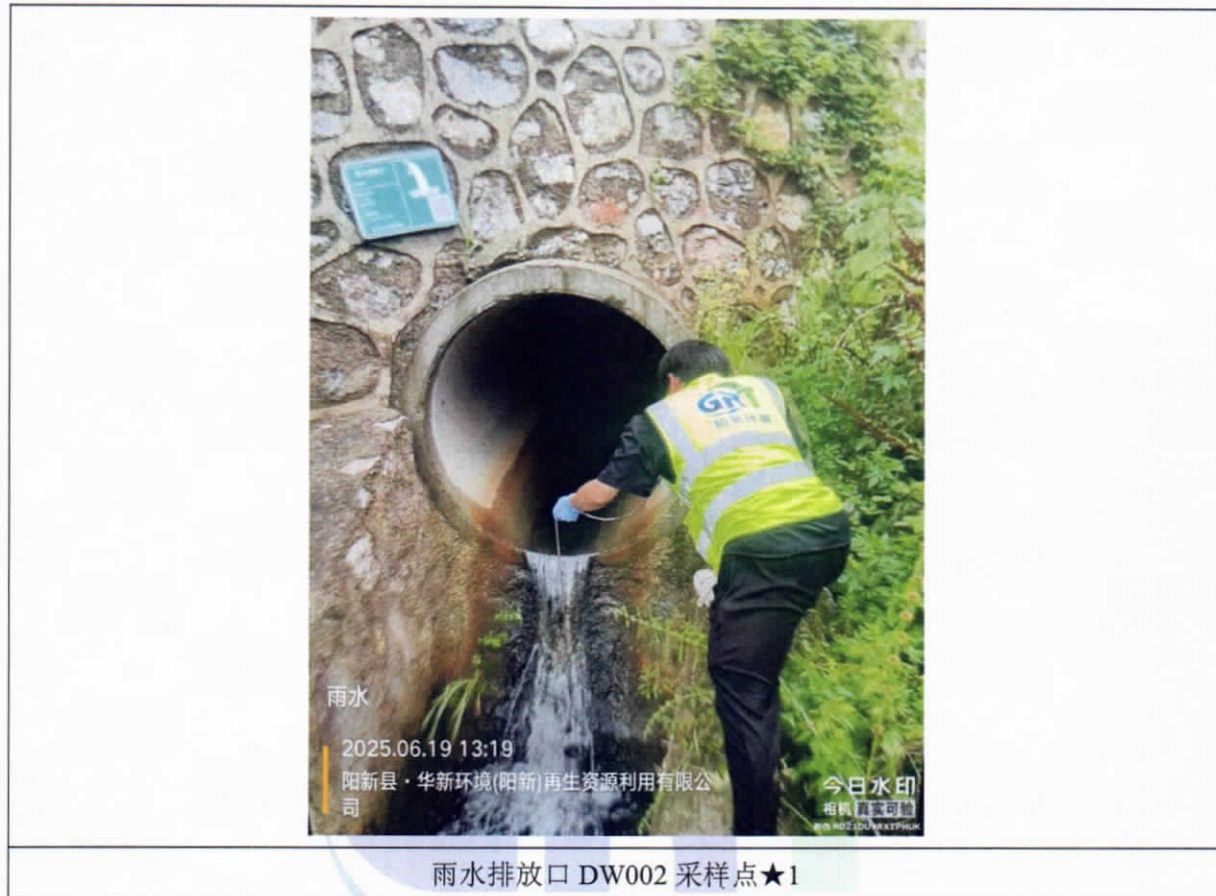
附图 2：现场检测照片
