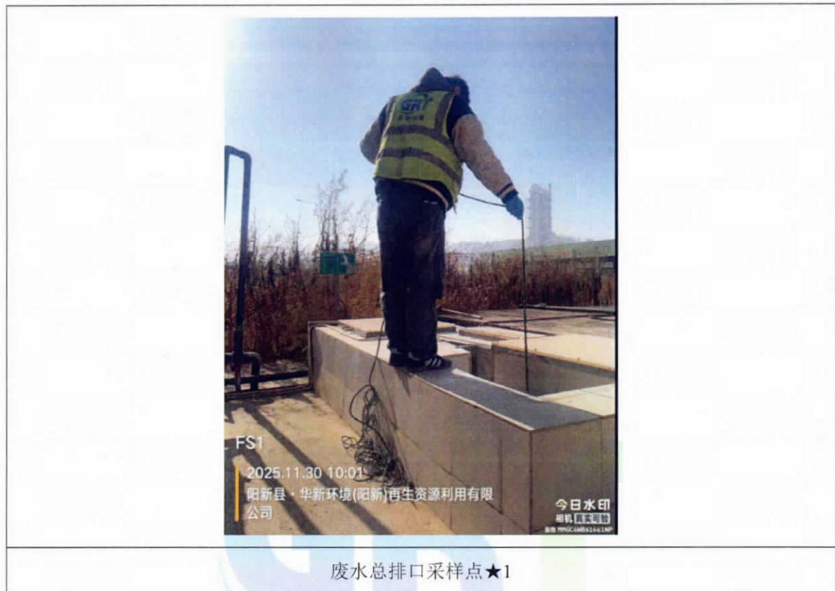
附图 2：现场检测照片
