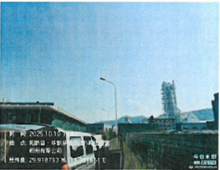
S2土壤采样点西方情形
