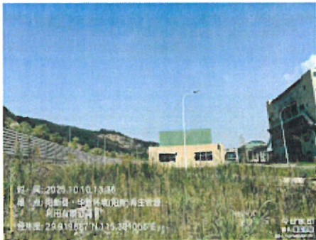
上游1号水质采样点西方情形
