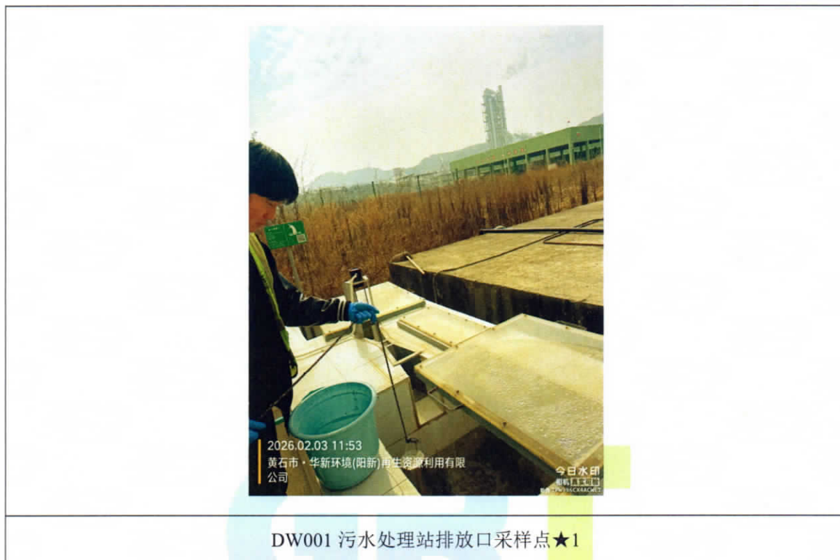
附图 2：现场检测照片
